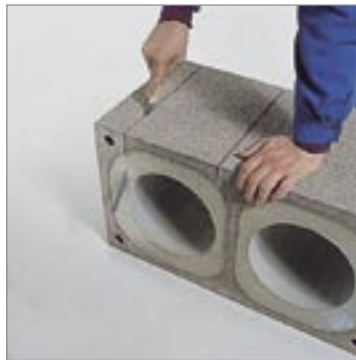
3.3 A szigetelő habot fűrészlappal vágjuk át.
