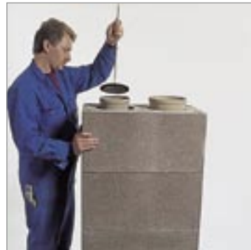
4.7 A kinyomódott hézagkittet a hézaglehúzóval húzzuk ki.
