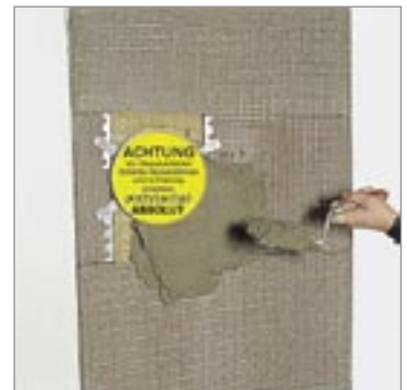
4.12 Bevakolni majd csak a gyűrűn kívül szabad. A habarcs-sablonon található koronggal a nyílást ideiglenesen be tudjuk takarni.
