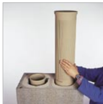
3.11 A másik kéménykürtőbe illesszünk egy normál 1,33 m-es profilcsövet.
