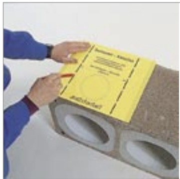
3.1 Tegyük a sablont a köpenytéglára és rajzoljuk fel a kivágási méretet.
