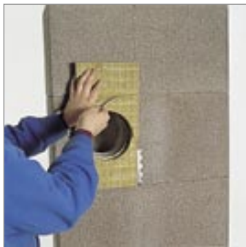
4.10 Vágjuk méretre az előlapot és a sarokvasak felhelyezésével illesszük a helyére.
