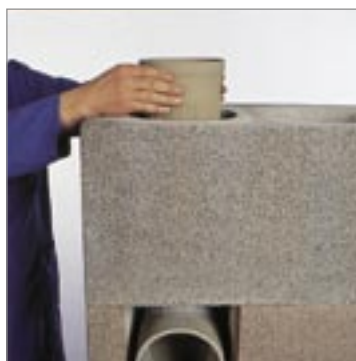
3.10 Tegyük fel a következő köpenytéglát a habarccsal megkent kivágott betonköpenyre, és ragasszuk be a helyére a 33 cm-es profilcsövet.
