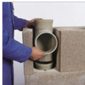
3.7 Tegyük be a füstcső-csatlakozót. L=33 cm 14-es belső átmérőig, L=66 cm 16-20 átmérők esetében.
