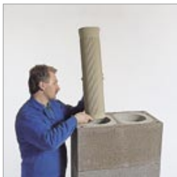
3.4 A füstcső-csatlakozó csomagból vegyük ki a 66 cm magas profilcsövet és illesszük a helyére. Alaposan ragasztózzuk be a profilcső ragasztási peremét.
