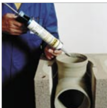
3.9 Hordjunk fel bőségesen ragasztót a cső belső peremére.
