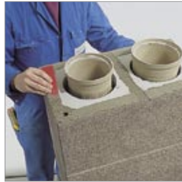
4.3 Hordjunk fel habarcsot a köpenytéglára, a sarokfuratokat hagyjuk szabadon, de a szigetelés és a sarokfurat közötti részt ne hagyjuk ki.
