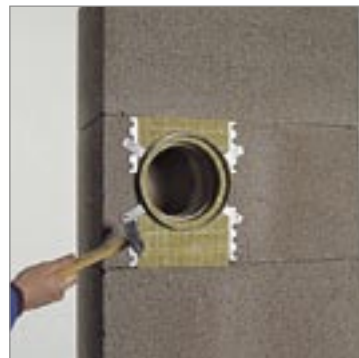
4.11 A vakolatgyűrűt a füstcső-csatlakozóhoz képest központosan illesztve szegeljük fel.
