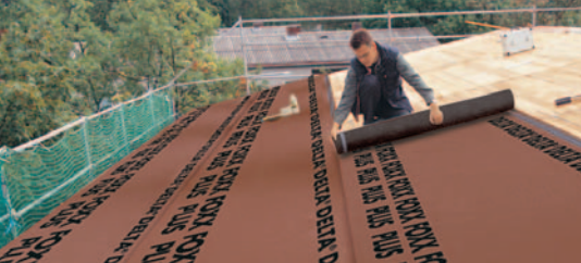
Fektetése az ereszszel párhuzamosan történik.
