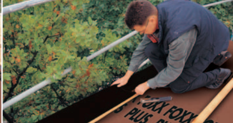
A fólia a deszkázat lezárásán végződjön.
